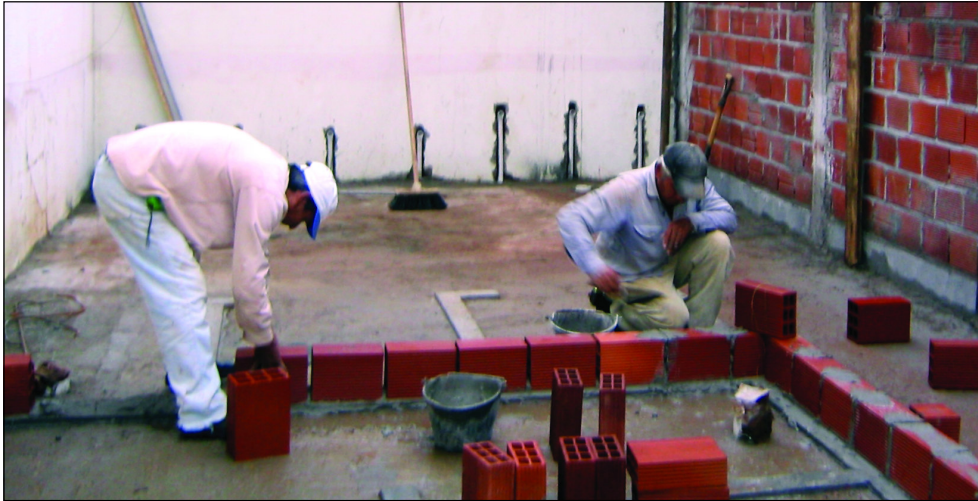
Las obras para construir tres aulas destinadas a la capacitación y la formación profesional para jóvenes y mujeres de San Gerardo ya están en marcha. FP
